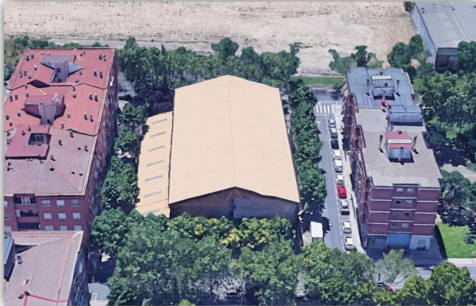
Los trabajos a realizar consisten en el desmontaje de 62 m<sup>2</sup> de placas de poliéster simple de los lucernarios existentes en cubierta actual, con transporte de material a vertedero autorizado.
