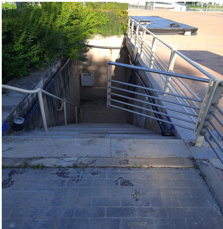
Puerta de acceso a depuradoras
