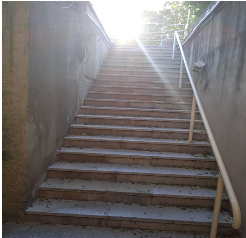
Escaleras de acceso a la depuradora
