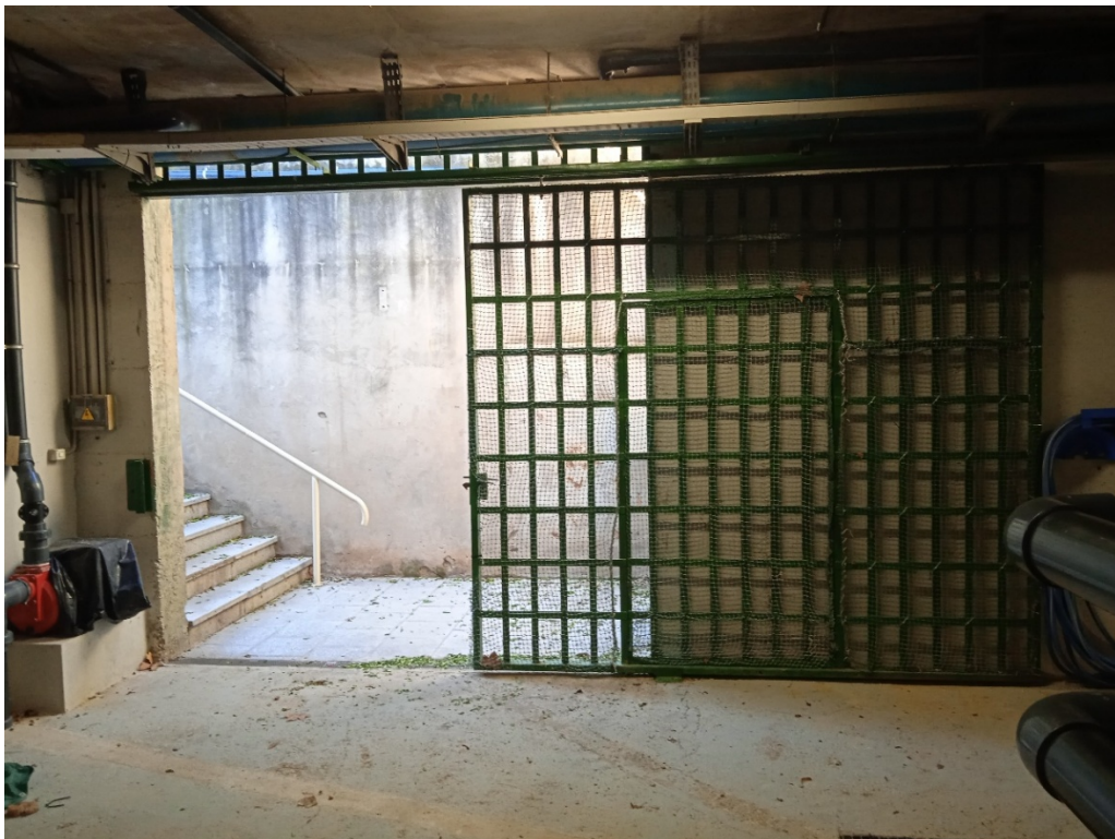
Puerta de inferior de acceso a la depuradora
